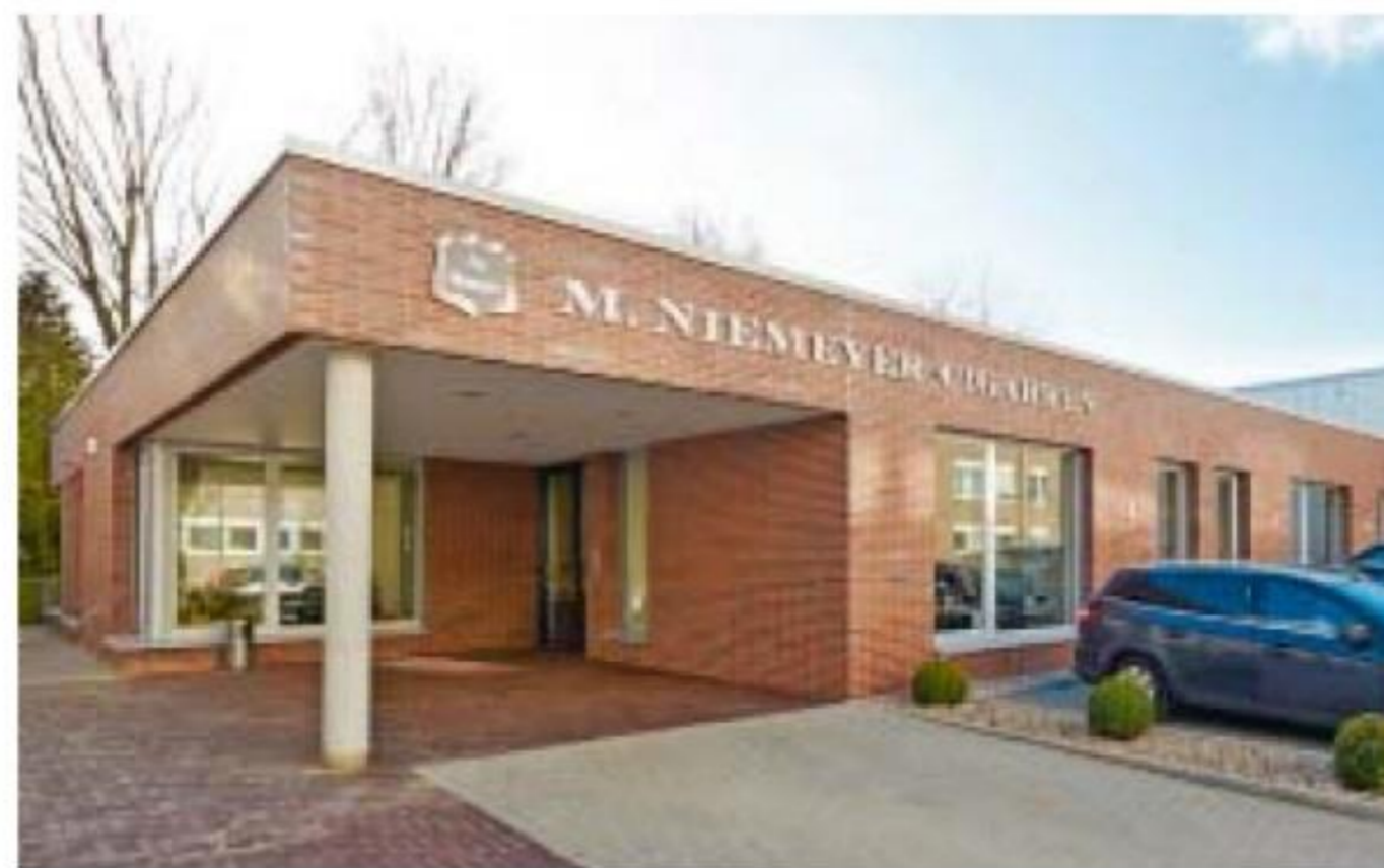
Pünktlich zum Firmenjubiläum wurde der Neubau der Firmenzentrale in der Bremer Airport-City fertig.
